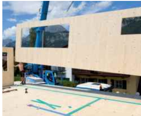
Sylodyn® Streifenlager, oberhalb der Rohdecke
