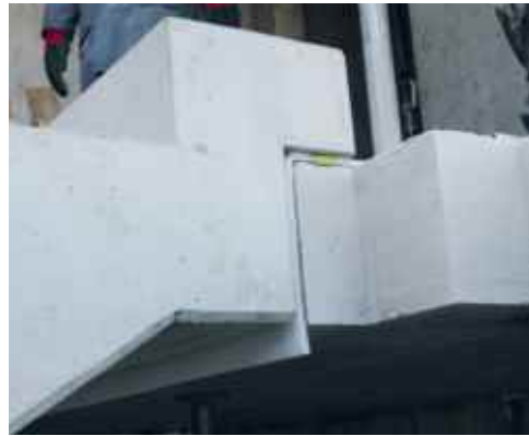
Treppenlager SB10 unter Fertigteildecke
