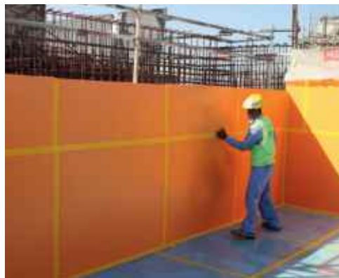
Poollagerung Jumeirah Gate Dubai
