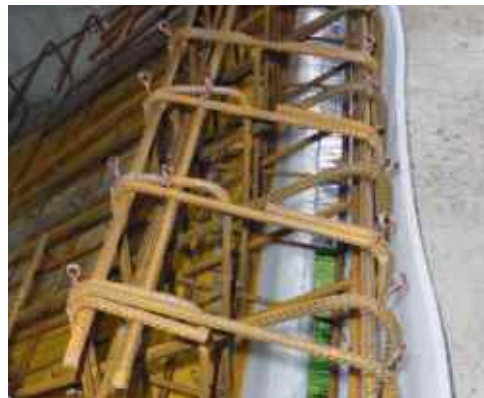
Treppenlager SB10 unter Ortbetondecke
