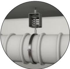
Anche le tubazioni utilizzate nell'impiantistica collegate alle fonti energetiche (RLT, BHKW ecc.) trasmettono vibrazioni meccaniche e devono essere tenute in considerazione durante la progettazione di un sistema di isolamento vibrazionale.
