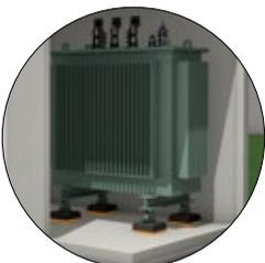
Le vibrazioni meccaniche vengono trasmesse dal nucleo del trasformatore al sottosuolo attraverso le superfici d'appoggio (ad es. i rulli). Il funzionamento dei trasformatori all'interno di un edificio o nelle immediate vicinanze viene percepito come un fattore di disturbo da chi abita e lavora nell'edificio stesso.
