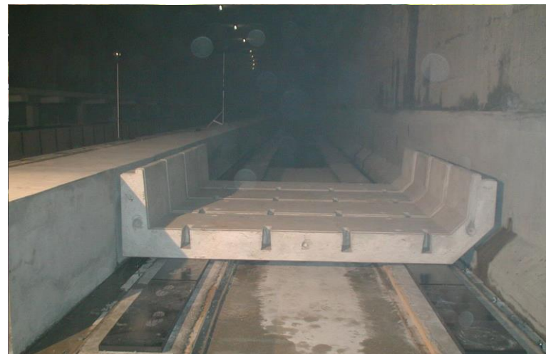
Masse-Feder-System / Troglagerung U-Bahn München
