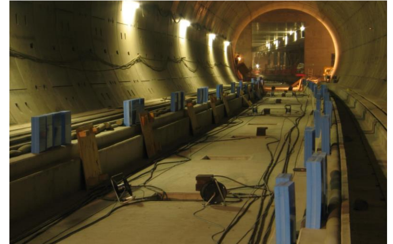
Vorbereitung der Betonage der Gleistragplatte mit Mannlöchern
