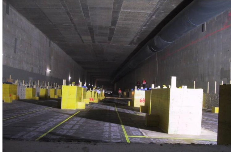
Vorbereitung der Herstellung der Gleistragplatte der FF
