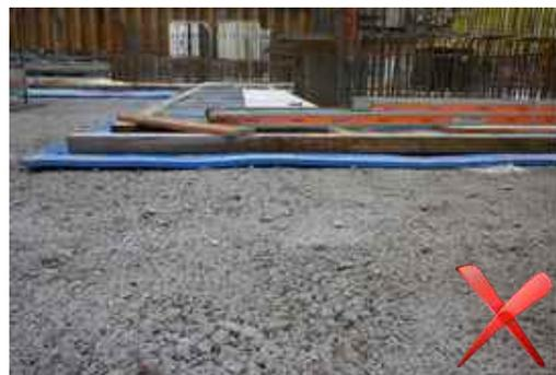
Für eine saubere Verlegung der Lagerelemente ist eine Sauberkeitsschicht zweckmäßig.
