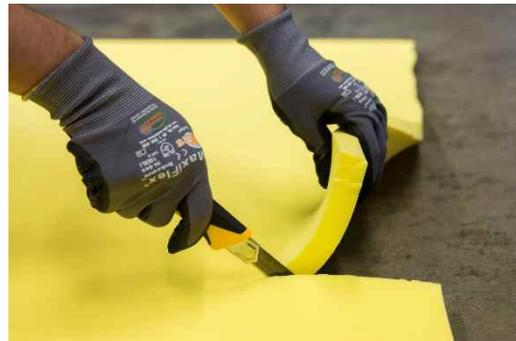
Nachträgliche Anpassungen der Lager-elemente können mit Hilfe eines Einwegmessers bzw. mittels Kreissäge einfach vor Ort vorgenommen werden.
