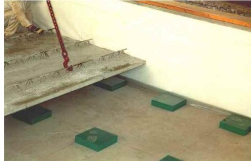
Die genaue Positionierung ist so zu wählen, dass sich das Lager mittig über dem lastabtragenden Bauteil befindet.
