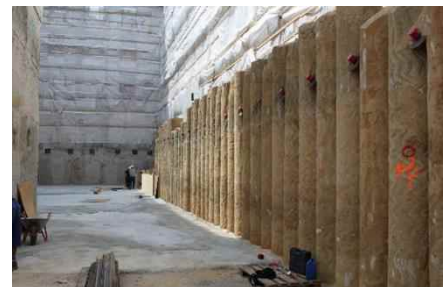
Abb. 2: Beispiel Bohrpfahlwand Quelle: G+K Spezialtiefbau
