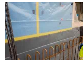
Abb. 9: Abgeklebte Stöße und Baufolie Quelle: Getzner
