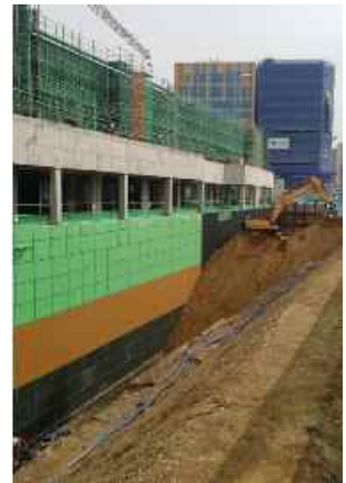
Abb. 1: Montierte Seitenmatten Quelle: Getzner
