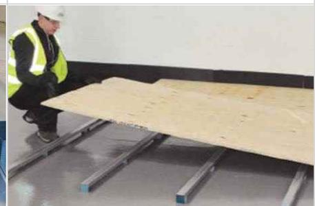
**5)** Verlegung der verlorenen Schalung (OSB – Platten).
