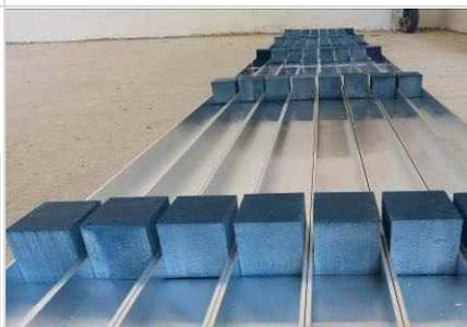
**4b)** Alternativ können die Floor Blocks auch im entsprechenden Abstand in ein passendes U Profil gedrückt werden. Diese müssen dann nur noch an die im Verlegeplan angegebene Position gehoben werden.
