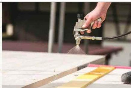
**5)** Optional können die Lager nun mit Sprühkleber oder mechanisch befestigt werden, um ein Verrutschen während dem Versetzungsvorgang der Holz-Elemente zu verhindern.
