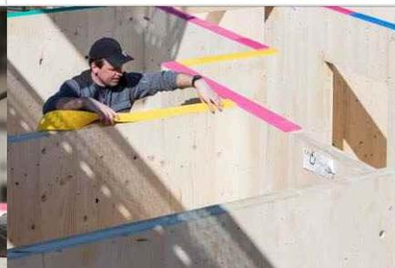
**6)** Verlegung der Lager entsprechend dem Verlegeplan. Die Lager können dabei stumpf gestoßen werden.
