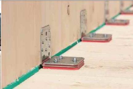
8) Kraftschlüssige Verbindungen zwischen den entkoppelten Elementen müssen ebenfalls entkoppelt werden. (z.B. ABAI105)
