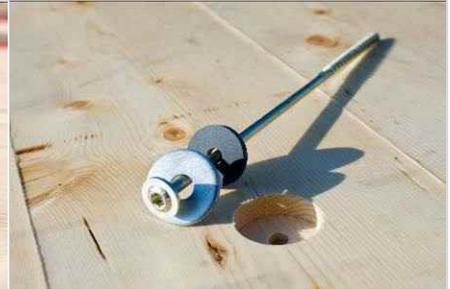
9) Verschraubungen müssen vorgebohrt werden. Um die Schraube zu entkoppeln sind elastische Unterlagscheiben zu verwenden.
