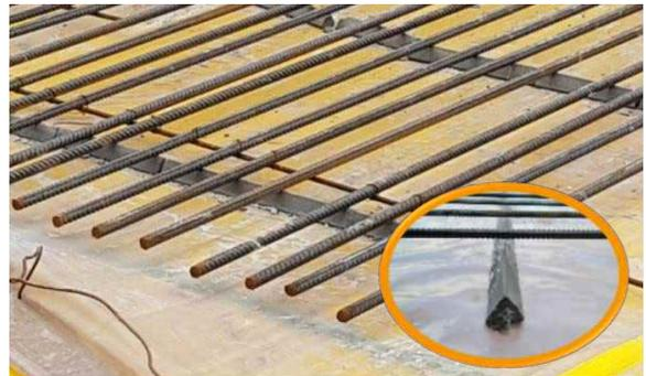
Um ein Eindrücken durch Abstandshalter zu vermeiden ist bei Matten mit geringer Dichte ( $\leq 400 \text{ kg/m}^3$ ) die Aufstandsfläche durch eine geeignete Unterlage zu vergrößern.
