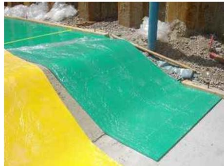
Vertiefungen bzw. Schrägen können abhängig von Materialtyp und Dicke ohne zusätzliche Sicherung verlegt werden.
