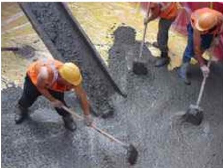
Auf die Matten bzw. auf die Baufolie kann direkt betoniert werden.
