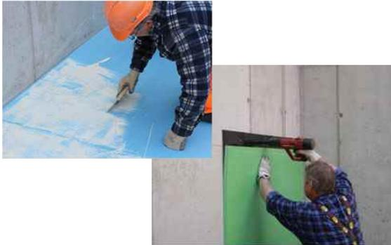
Befestigung der Seitenmatten durch Verklebung oder Verwendung einer Montagelasche.
