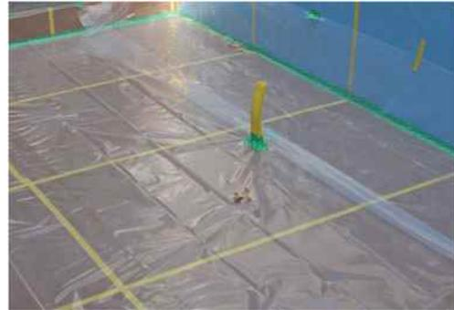
Um die Gefahr von Schallbrücken weiter zu verringern, können die Matten vor dem Betonvorgang optional noch abgedeckt werden (z.B. mittels Baufolie).
