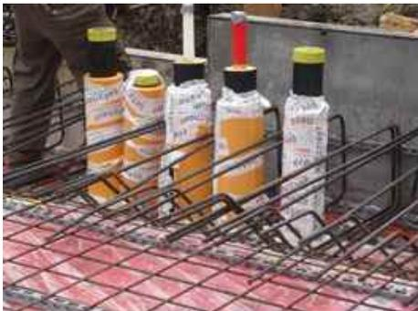
Durchdringungen wie Rohrleitungen werden mit Sylomer® bzw. Sylodyn® ummantelt und mit Bauklebeband fixiert.
