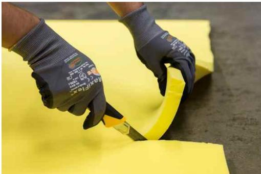
Nachträgliche Anpassungen der Mattenlänge können mit Hilfe eines Einwegmessers bzw. mittels Kreissäge einfach vor Ort vorgenommen werden.
