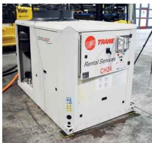
La pompa di calore è stata completamente disaccoppiata prima mediante piastra antivibrante di REFCO e successivamente mediante i supporti antivibranti Isotop® DSD e Isotop® DZE di Getzner.
